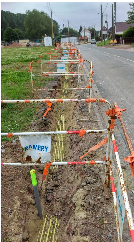
Installation du Gaz de ville
