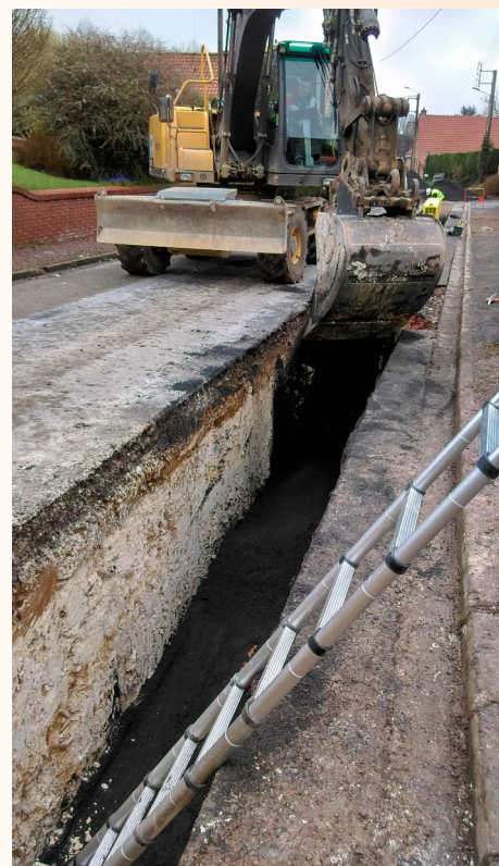
Assainissement rue des moulins
