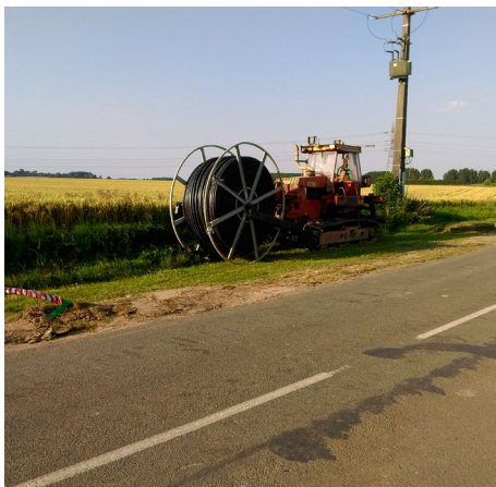
Installation de la fibre optique
