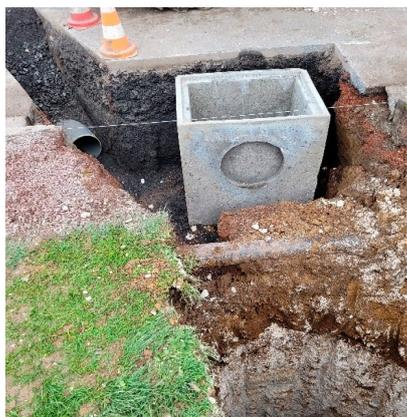
3 puits d'infiltration de 6m de profondeur chacun ont été créés Rue des Moulins afin de retenir le plus en amont possible les volumes d'eaux pluviales qui finissent par s'écouler rue de la gare et occasionner des inondations.
